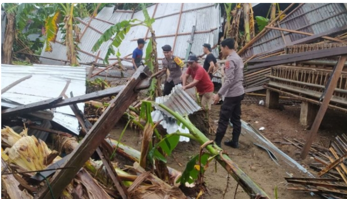
Bangunan rumah peternakan ayam milik warga Polejiwa roboh rata dengan tanah usai diterjang angin puting beliung
